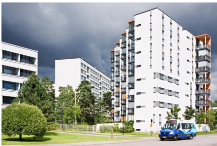
Asuntorakentamista Kontulassa. (Simo Karisalo)
