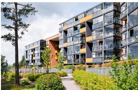
Asuntorakentamista Kannelmäessä. (Simo Karisalo)
