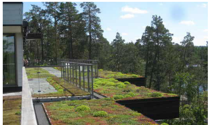
Esimerkkejä tiloja rajaavista piharakenteista sekä viherkatosta
