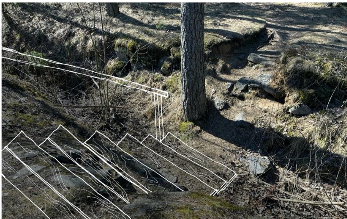
Kuva 33. Sivureitillä olevaa haastavaa haudan ylitystä parannetaan rakentamalla haudan itäseinälle portaat. Länsiseinälle kivenlohkareet muodostavat luontaisia askelmia.
