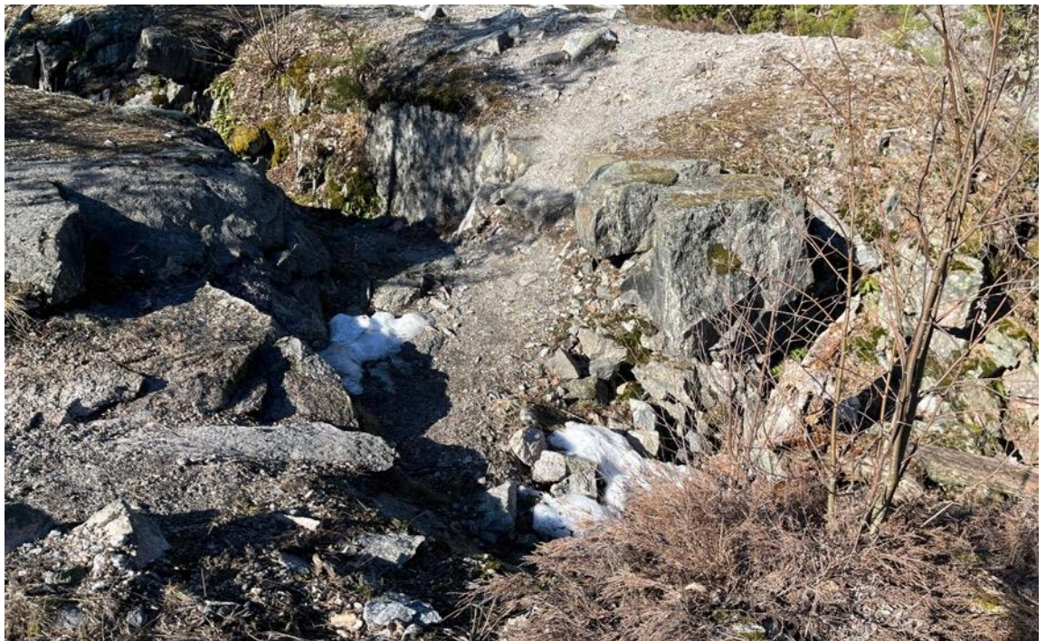
Kuva 22. Kiviaineksella täytetty haudan ylityspaikka.
