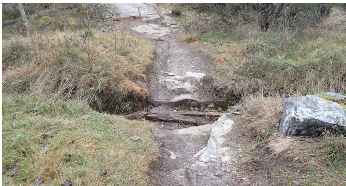
Kuva 34. Nykyinen polkusilta muodostuu hautaan heitetystä oksista ja rangoista.
